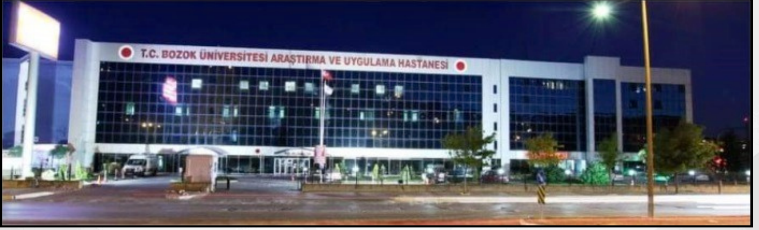
Yozgat merkezde bulunan eski Hastane Binası 2010-2018
